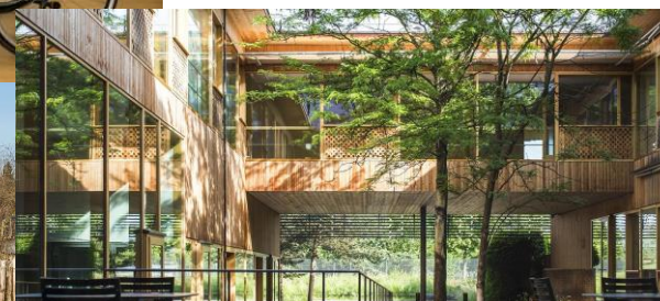
Fotos: Herzog de Meuron, Website REHAB
